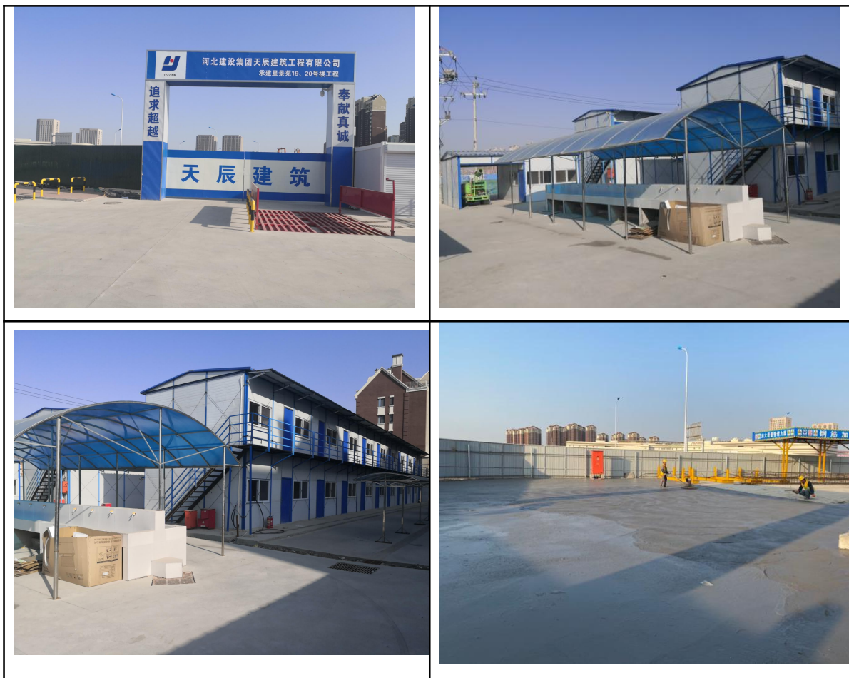
水土保持措施
