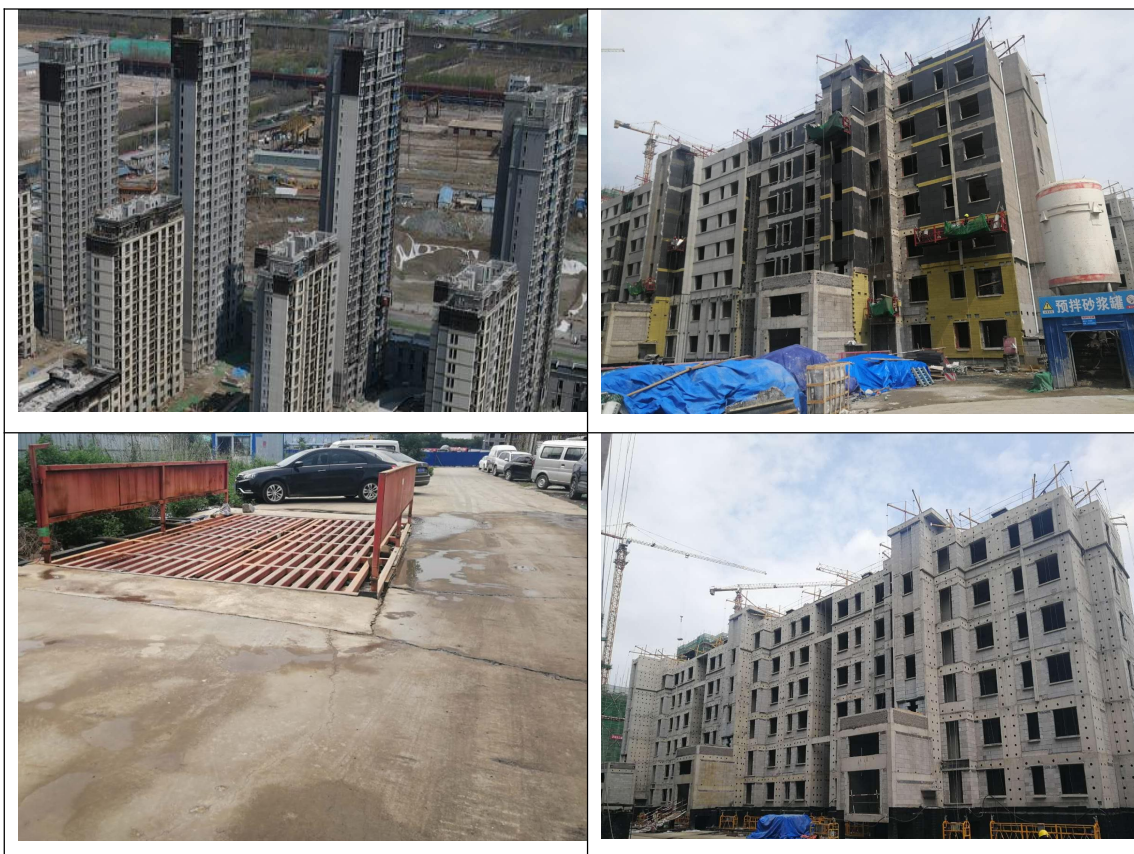
附图 3. 现场施工照片
