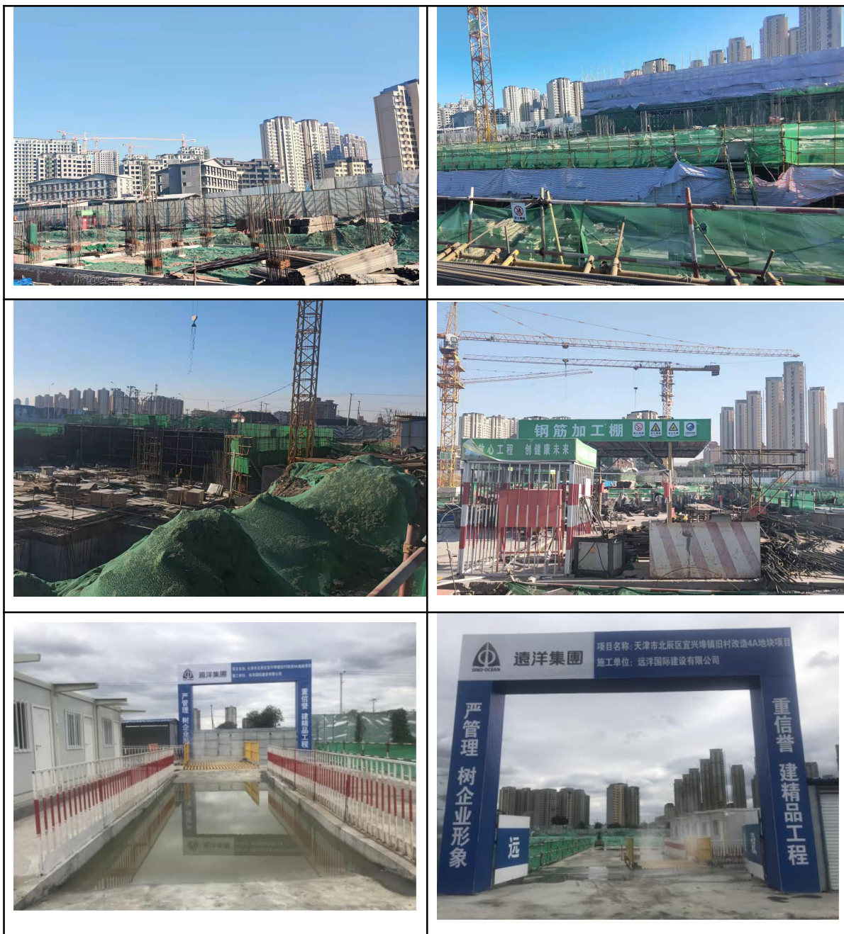
水土保持措施
